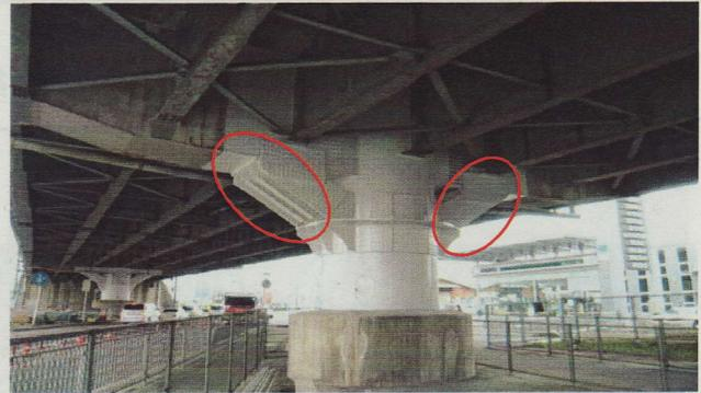
— 橋梁補修（鋼製橋脚隅角部の補修） —
