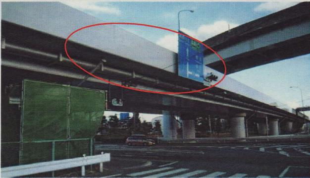
— 橋梁補修（一般道路交差部桁下のコンクリート剥落防止） —
